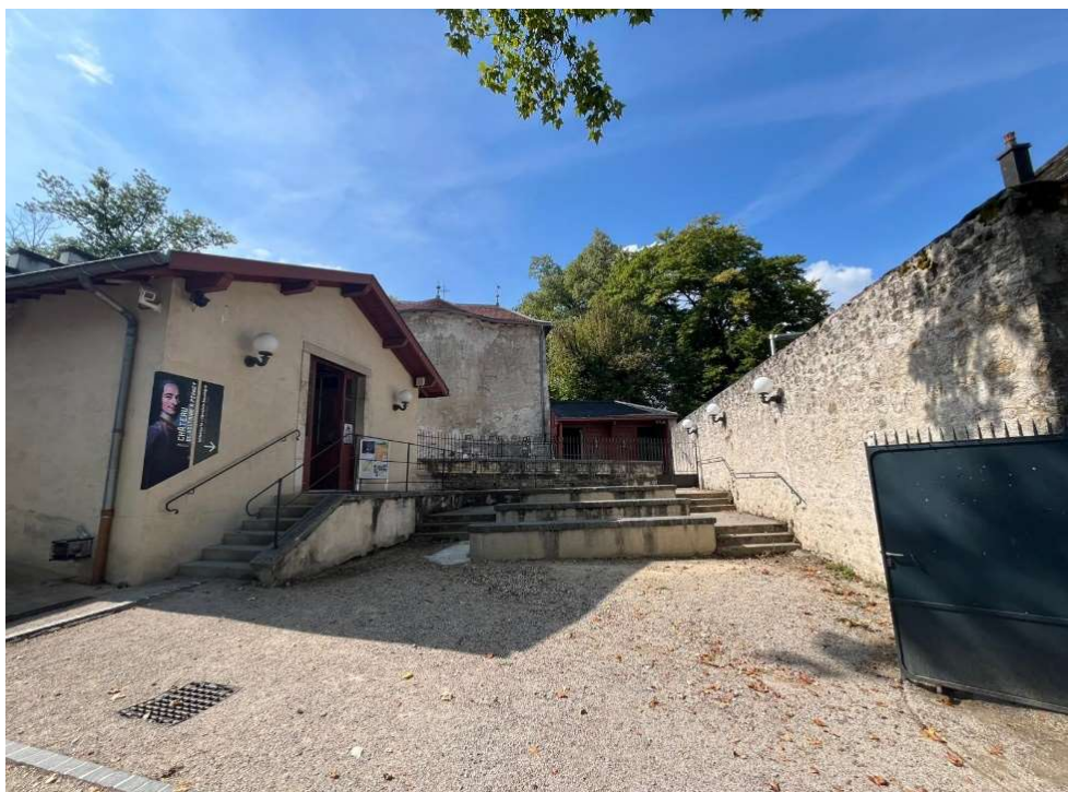
Légende : cour d'entrée. A gauche : bâtiment d'accueil-billetterie-boutique. Au centre : rampe d'accès. A droite : portail d'entrée.
